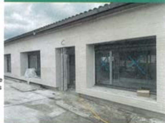
École primaire Renée Lacoude Isolation du bâtiment
