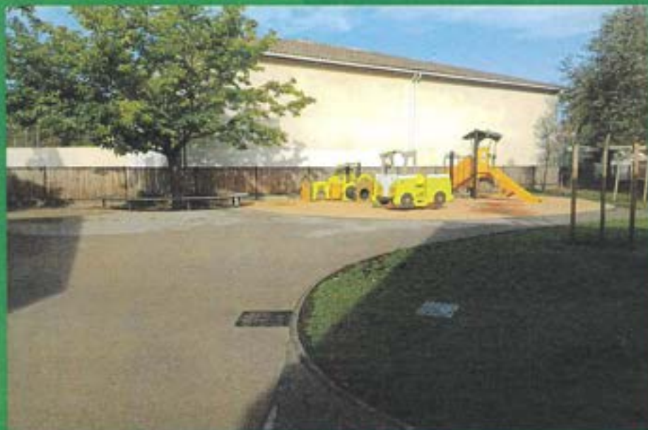
Des enrobés végétaux beige et drainant pour réduire l'effet chaleur
